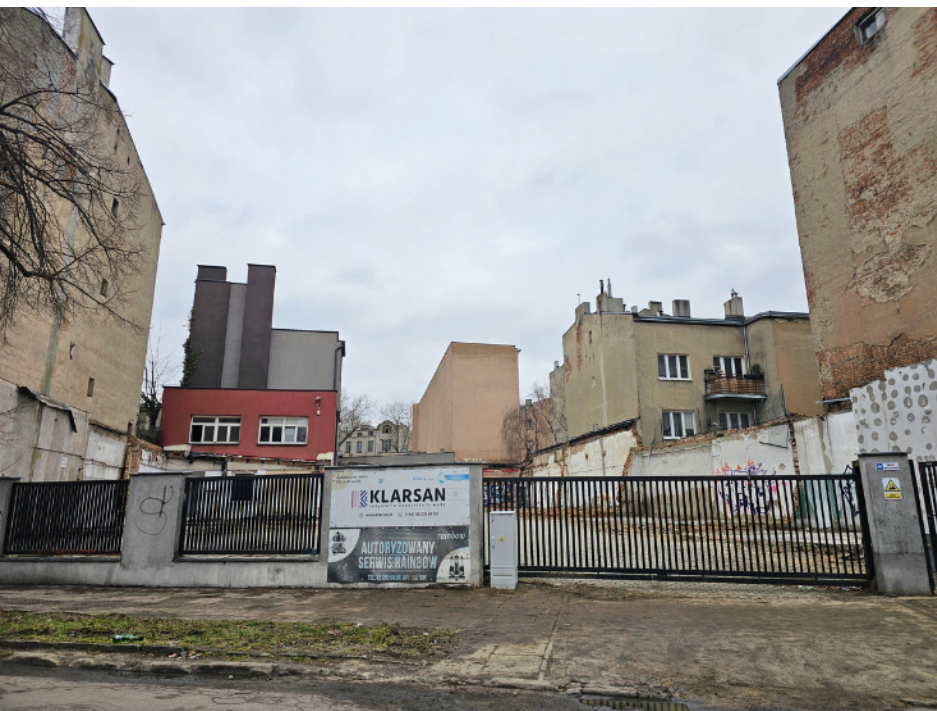
WIDOK NIERUCHOMOŚCI OD STRONY UL. LIPOWEJ
